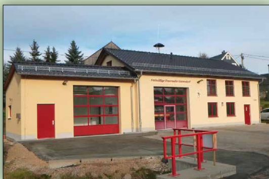
Anbau eines Einsatzfahrzeugstellplatzes an das Feuerwehrgerätehaus der Freiwilligen Feuerwehr Garnsdorf
